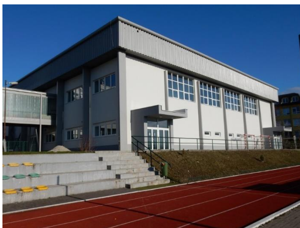
Športová hala pri Spojenej škole, Rosinská cesta, Žilina
