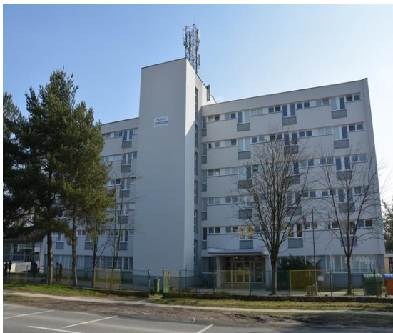
Spojená škola, Rosinska cesta, Žilina - Internát
